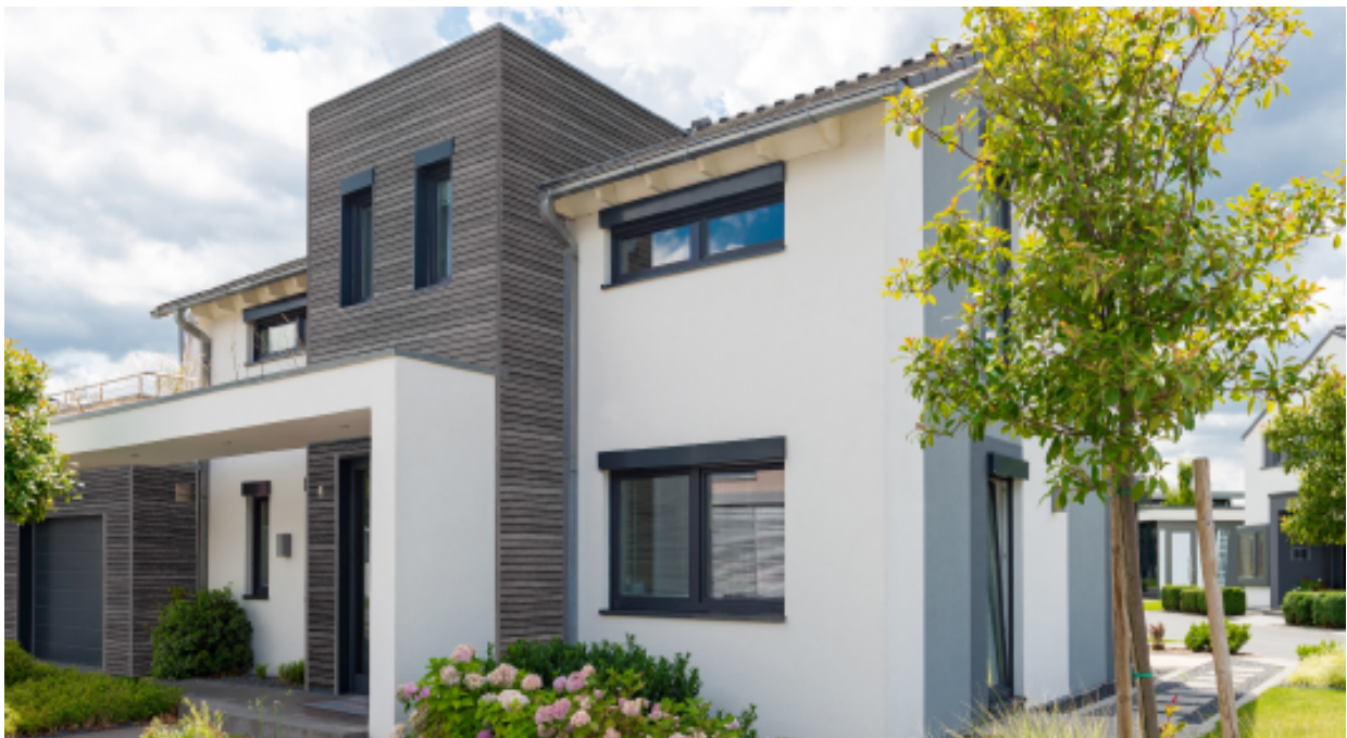
Ansicht auf eine fertig verkleidete Fassade.
